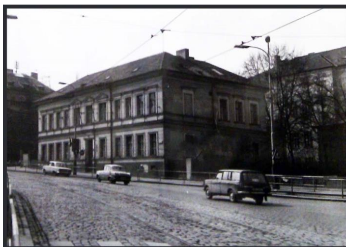
Obrázek č. 15 Vzhled budovy MŠ v roce 1967
