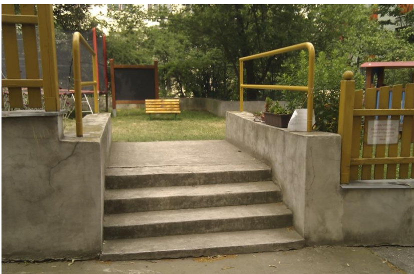
Obrázek č. 35 Terén celé druhé zahrady je oproti okolí vyvýšen a oplocení od cesty je zde tvořeno dřevěným plotem s podezdívkou, která vyrovnává převýšení. Vstup z veřejně přístupné cesty je otevřený, přestože zahrada je určena pouze pro potřeby mateřské školy.
