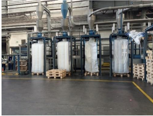
Obrázek 21: Stanice plnění žoků
