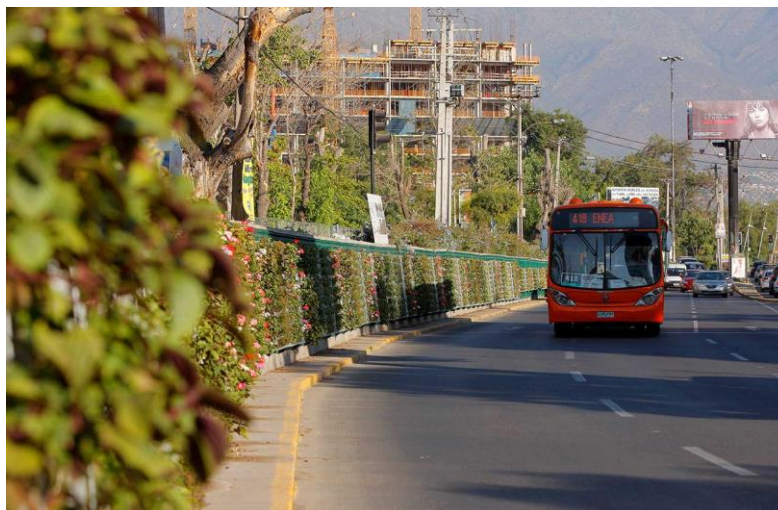
Obr. 3: Protihluková stěna Canevaflor, Chile, 2013. (Autor: Canevaflor, 2013)
