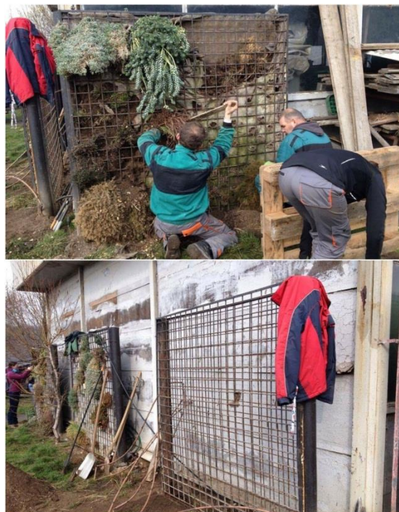
Obr. 87: Shora dolů: Vyjmutí starých rostlin a demontáž staré geotextílie na stěnách D a E. (Autor: Kristýna Divišová)
