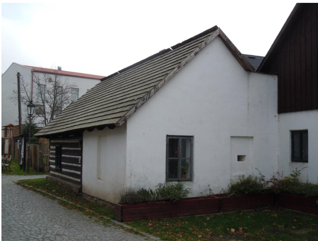
Obr. č. 2: domek čp. 62 – zadní pohled, zdroj: foto Šárka Teplá
