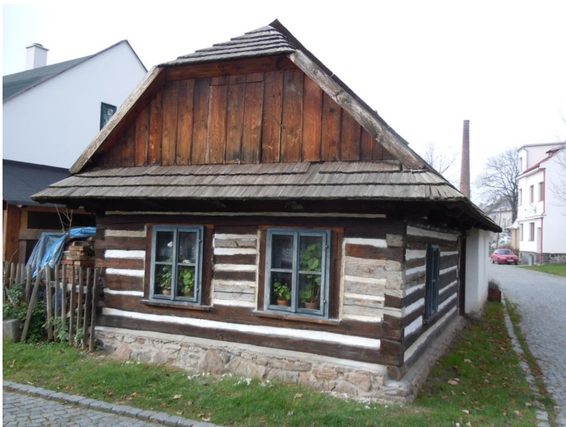
Obr. č. 1: domek čp. 62 – přední pohled, zdroj: foto Šárka Teplá
