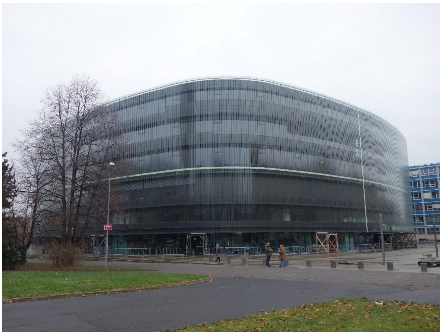
obr. 42 Budova NTK, Projektil Architekti, 2009
