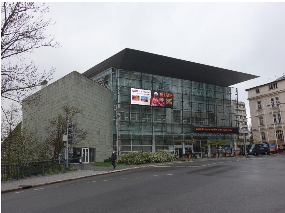
obr. 12 Budova KVK Liberec, průčelí, Radim Kousal, 2000
