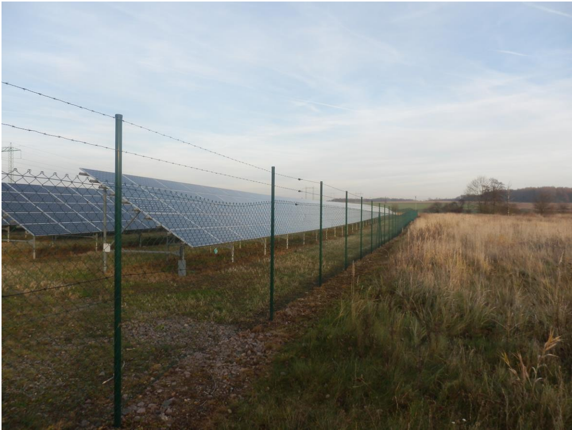
Příloha č. 6: Oplocení fotovoltaické elektrárny v části obce Klenovka (Zdroj: archiv autora)
