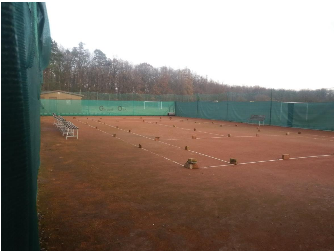
Příloha č. 7: Multifunkční sportovní hřiště v části obce Klenovka (Zdroj: archiv autora)
