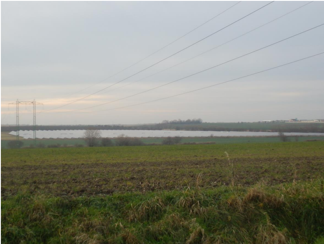
Příloha č. 2: Fotovoltaická elektrárna v části obce Klenovka (Zdroj: archiv autora)
