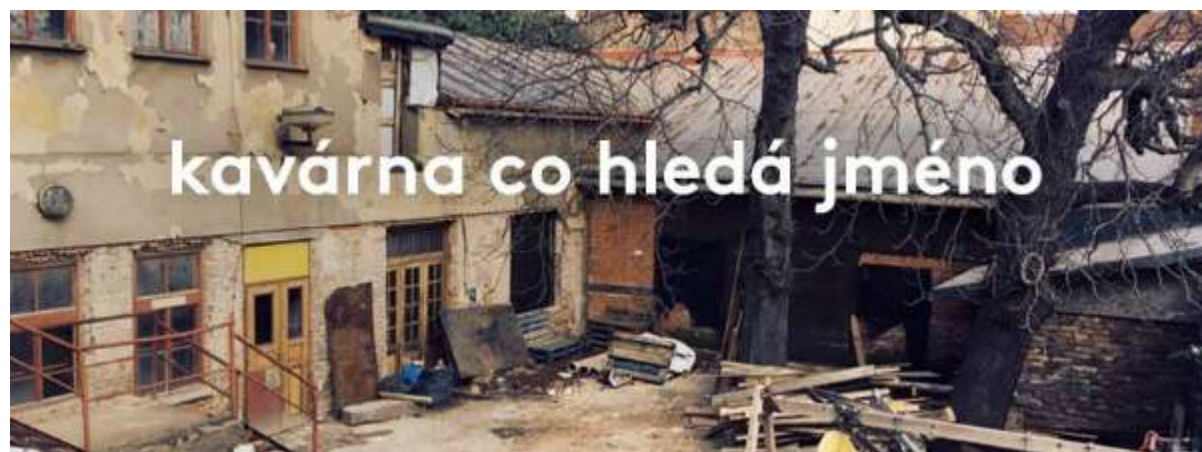
Obrázek 3: Kavárna v průběhu rekonstrukce (zdroj: www.bngr.cz)
