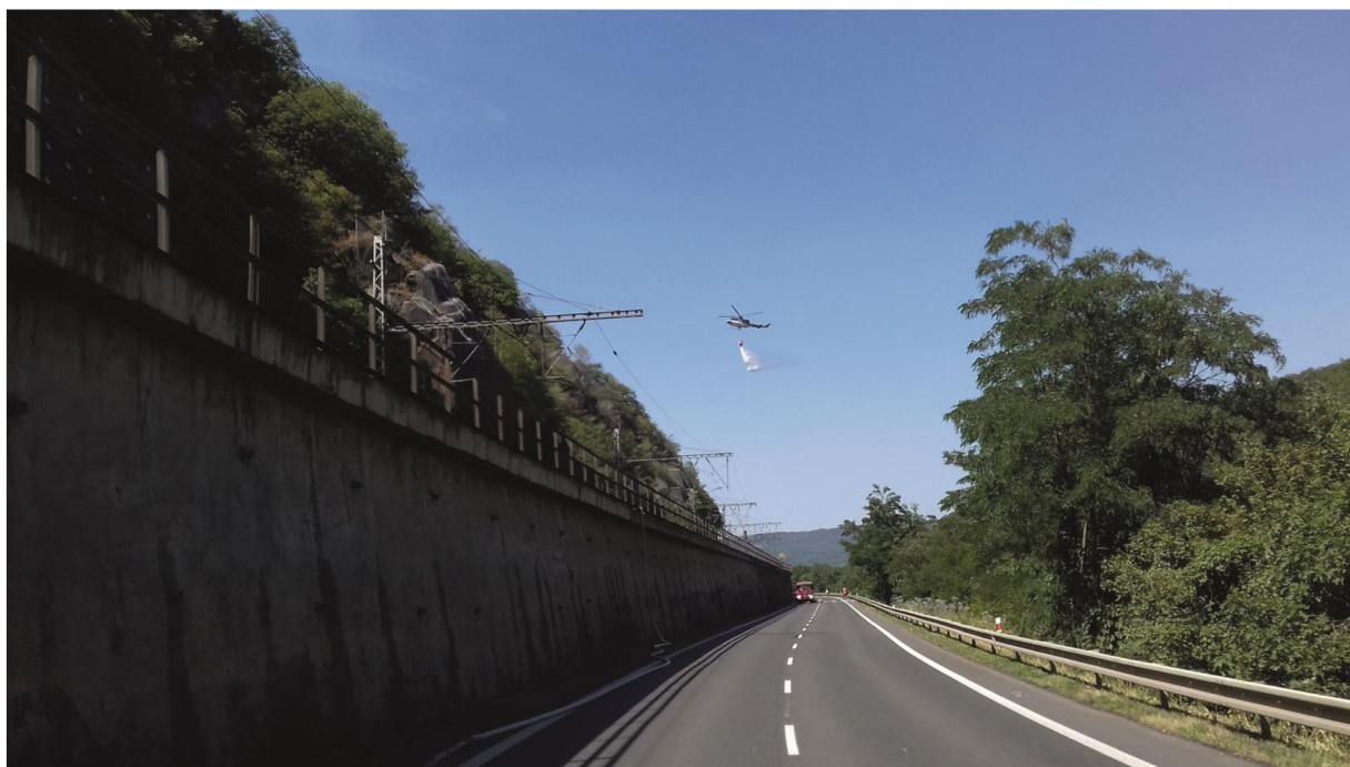
Obrázek č.6 Požár travního a lesního porostu podél trati vedoucí z Ústí nad Labem do Lovosic, zdroj: časopis
