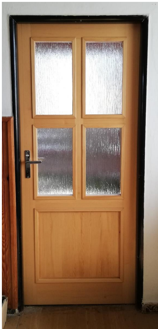
Obrázek 58 - Dveřní křídlo v ocelové zárubni
