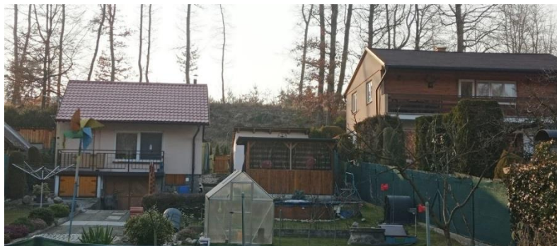
Obr. 6: Chaty v osadě Podhůra Zdroj: vlastní fotografie, 19. 3. 2022
