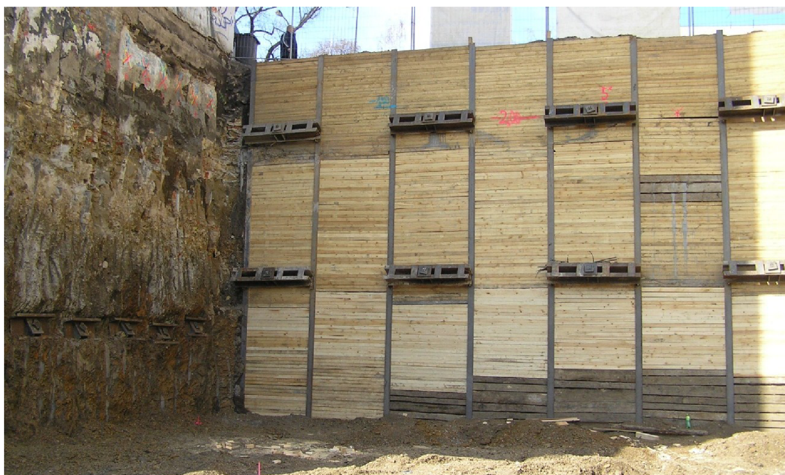
Obr. 47 Příklad záporového pažení kotveného ve dvou úrovních [21]
