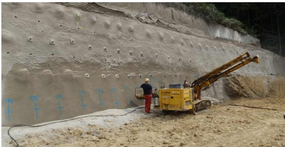
Obr. 9 Provádění vrtných prací pro osazení zemních hřebíků [7]
