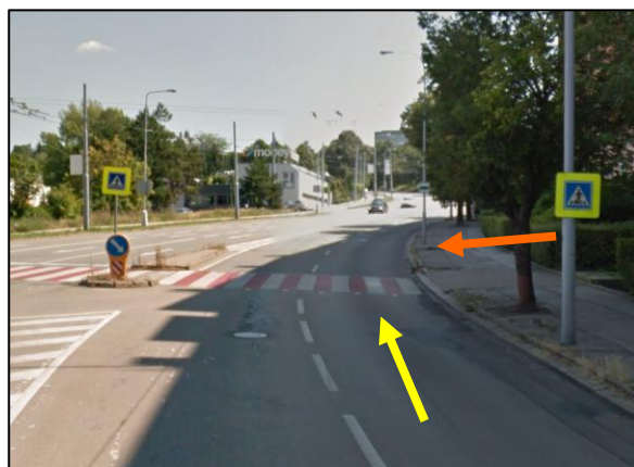
Obr. 47: Přechod B_P4 – ulice Drobného (u zimního stadionu), Brno [59]
