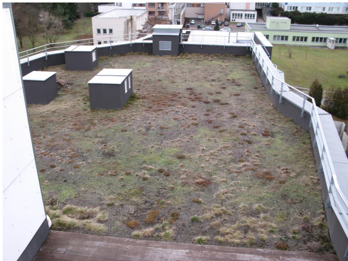
Foto 5: Pohled z 9. NP na nejnvýše položenou zelenou střechu, plocha "A", přibliženo. Z fotografie je zřejmý stav výsadby ze sazenic po pěti letech. Mocnost substrátu 3 cm je pro rostliny extrémním stanovištěm. (Zdroj: autorka práce)
