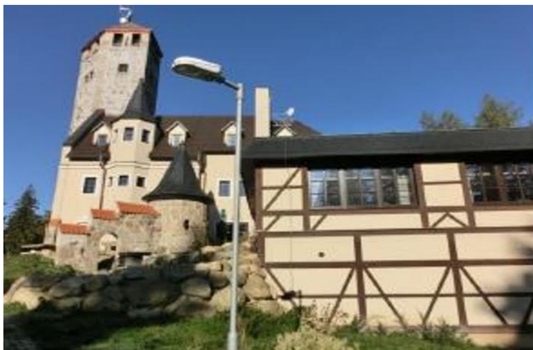
Obr. č. 4: Severní pohled na vydražený areál Liberecké Výšiny - Starý Harcov [44]
