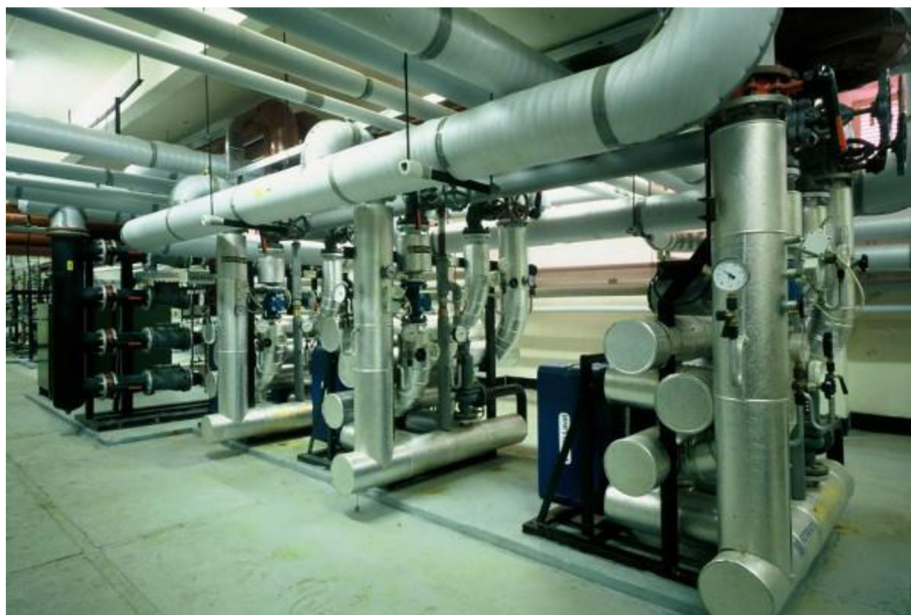
Obr. 1 Blokova výměňková stanice voda – voda [1]
