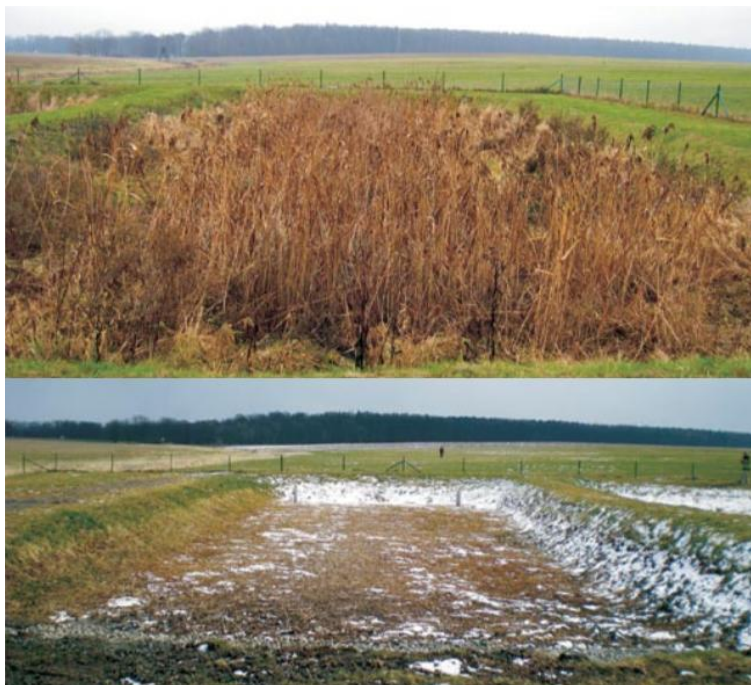
Obr. 25: Vegetační čistírna Břehov u Českých Budějovic před posečením (horní fotografie, únor 2008) a po posečení (dolní fotografie, březen 2008). Foto Jan Vymazal
