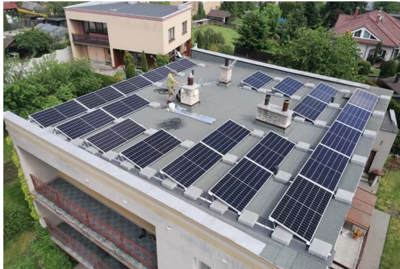
Obr 1.9 Ukázka instalace fotovoltaiky na ploché střeše [17].
