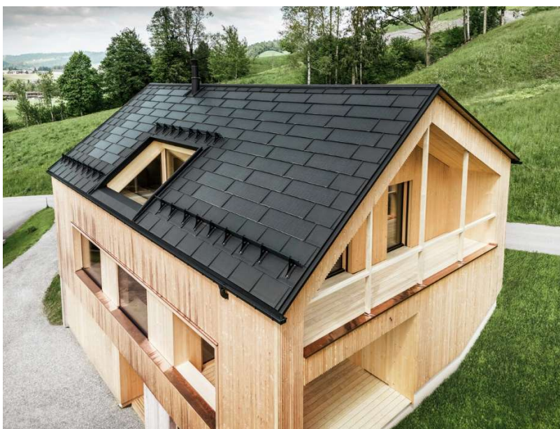
Obr 1.8 Ukázka sedlové střechy s integrovanými solárními panely [16].
