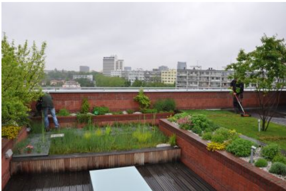
Obr. 5: Ukázka intenzivní vegetační střechy ( www.krytiny-strechy.cz )
