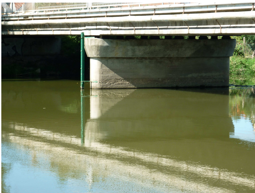
Obr. 28 – Silniční most v městské části Louka (130,30 km)
