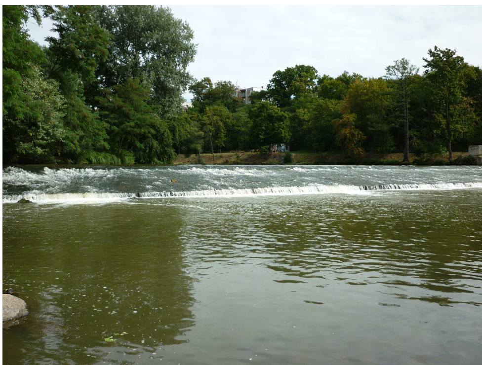
Obr. 30 – Jez v městské části Louka (130,75 km)
