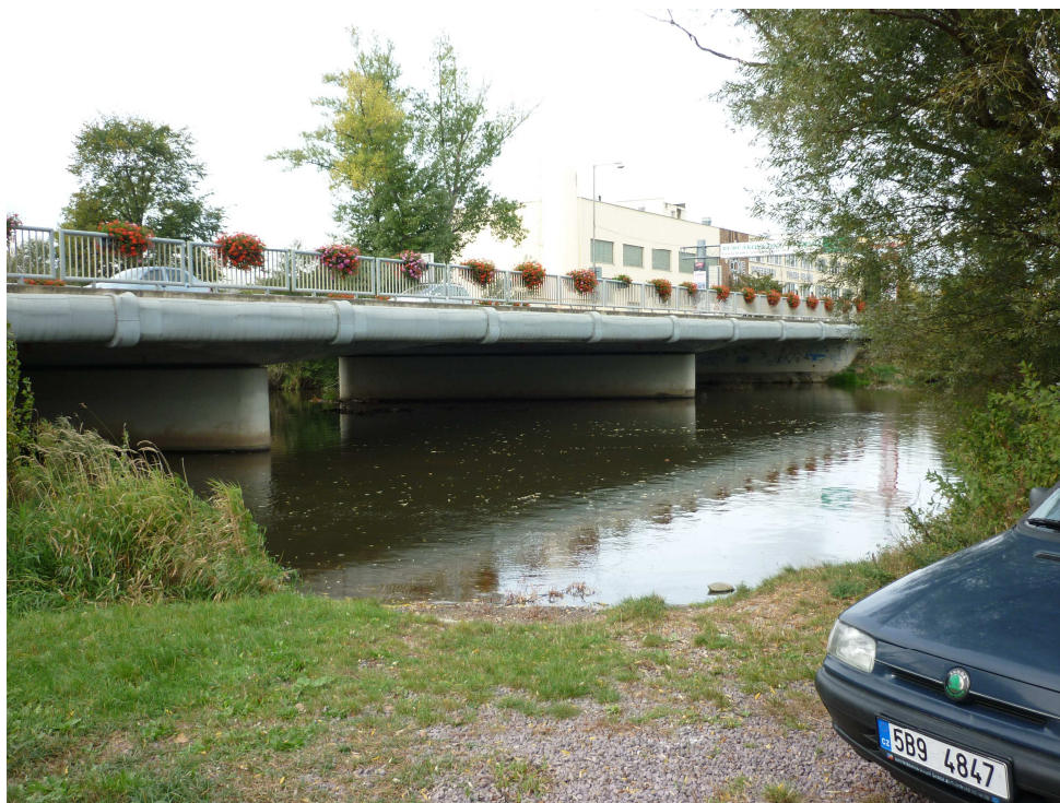
Obr. 25 – Silniční most Oblekovice (128,85 km)
