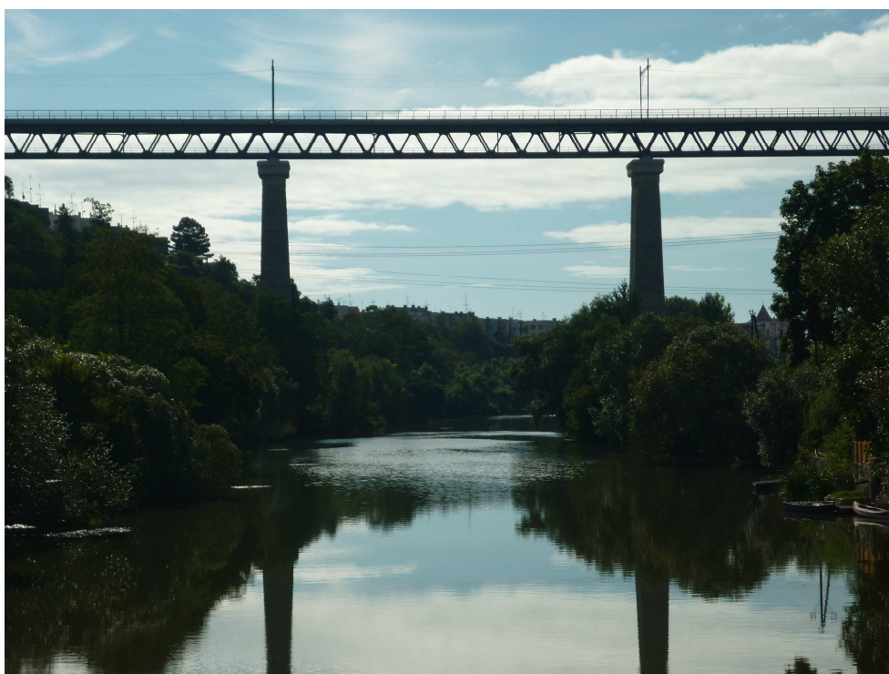
Obr. 32 – Železniční most č.2 (131,50 km)
