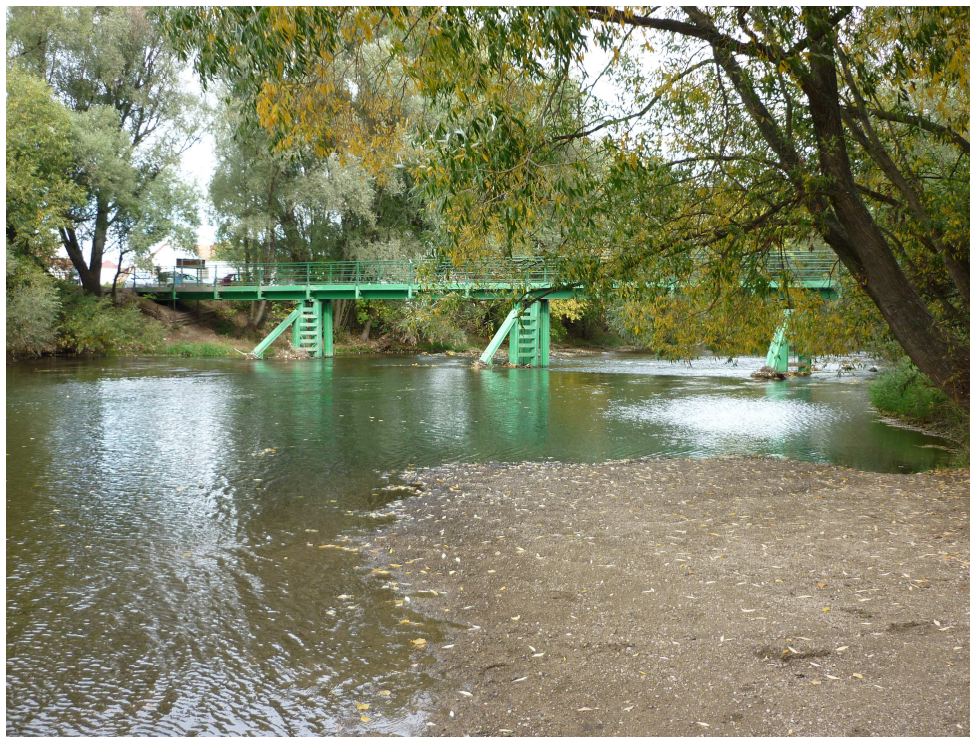
Obr. 23 – Pěší most v městské části Dobšice (126,95 km)
