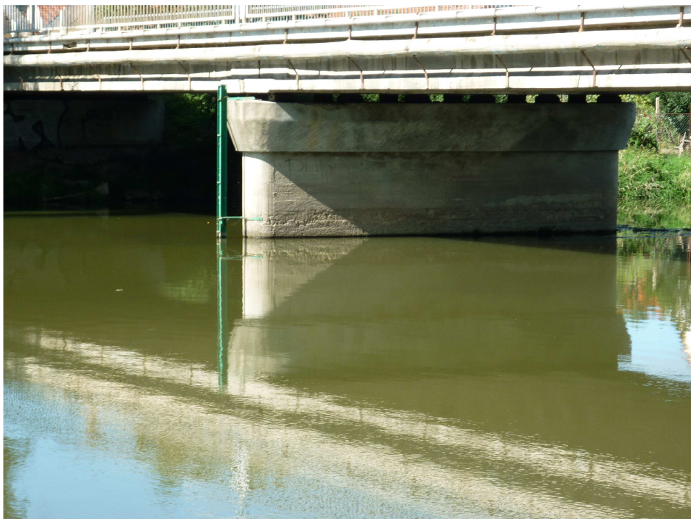
Obr. 28 – Silniční most v městské části Louka (130,30 km)
