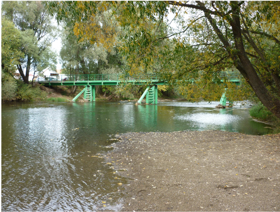
Obr. 23 – Pěší most v městské části Dobšice (126,95 km)
