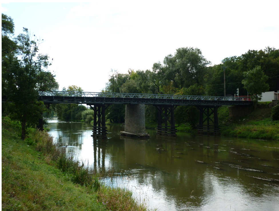
Obr. 33 – Silniční most (132,40 km)
