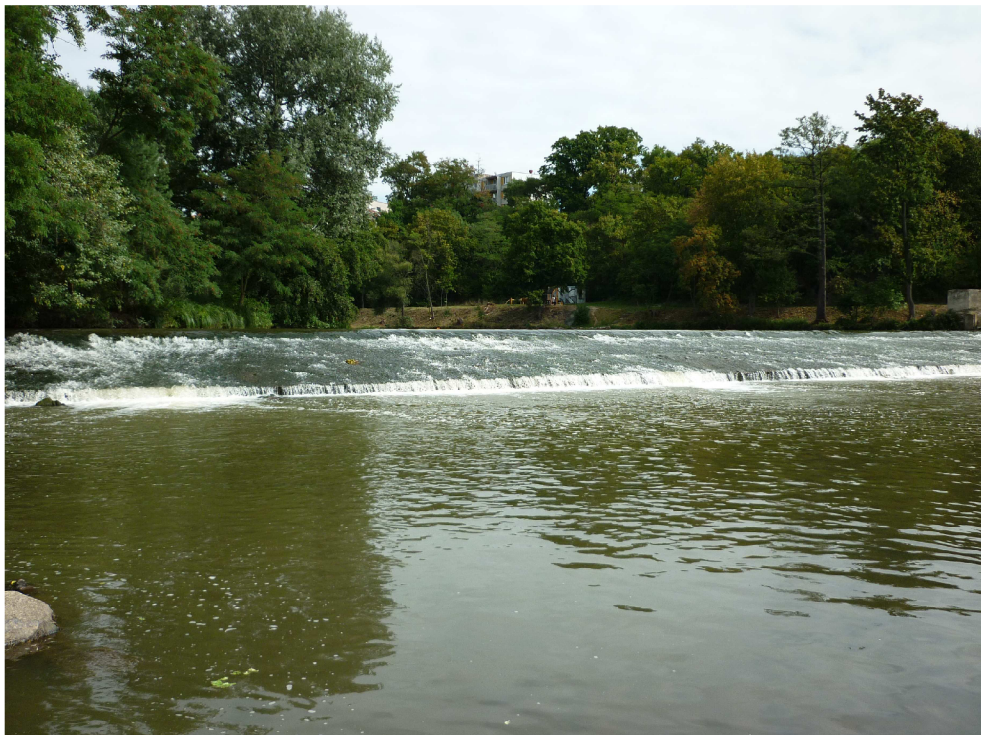
Obr. 30 – Jez v městské části Louka (130,75 km)
