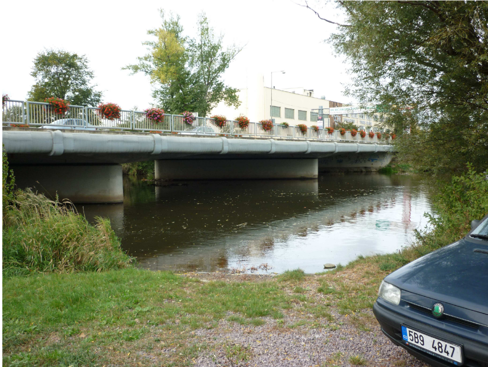
Obr. 25 – Silniční most Oblekovice (128,85 km)
