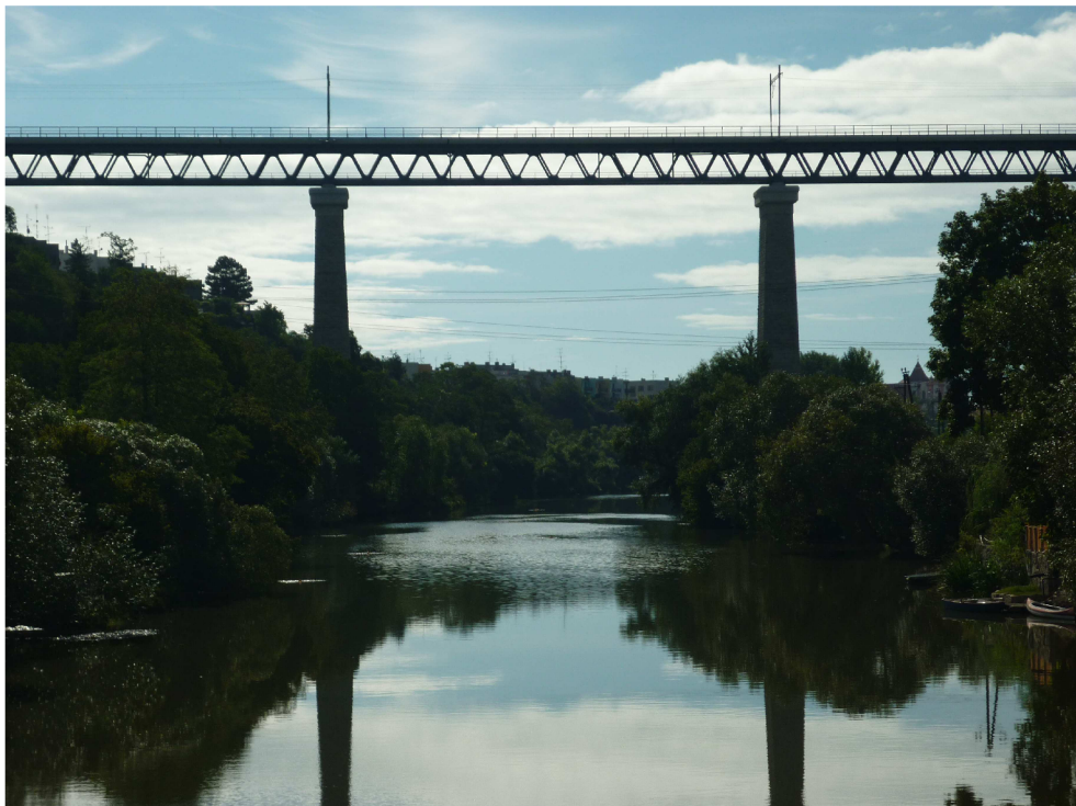
Obr. 32 – Železniční most č.2 (131,50 km)
