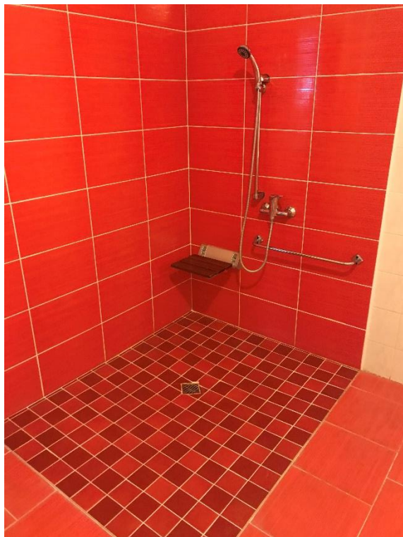
Obrázek 1 Ubytovací zařízení č. 1 - sprchový kout Zdroj: Foto: Tláskalová (2021)
