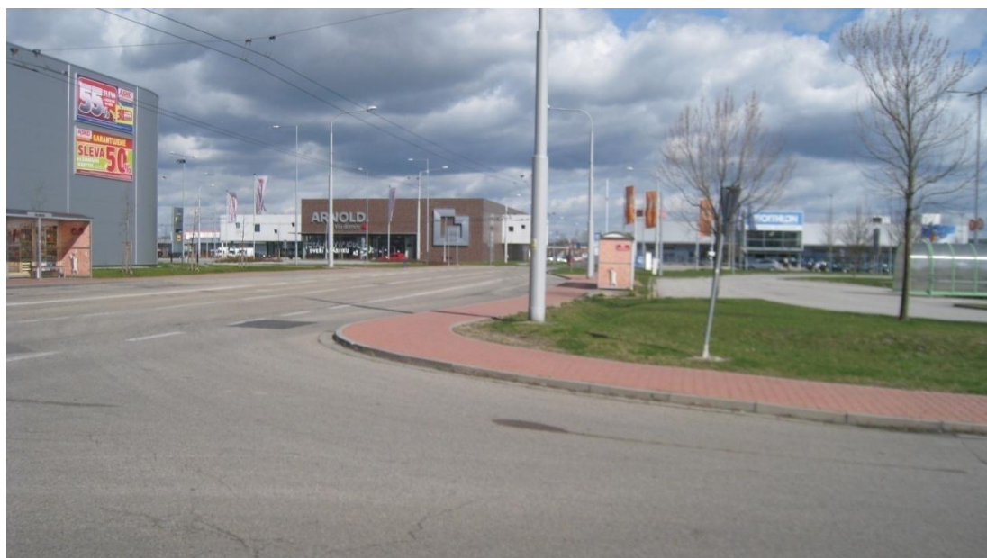
Foto č. 2: Komerční zástavba v katastrálním uzemí České Vrbné; zdroj: Kristýna Březovská
