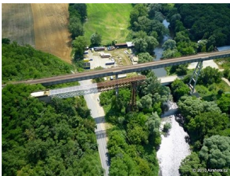
obr.10: Letecký snímek nového mostu a zachované části starého mostu. [zdroj: Airshots.cz]
