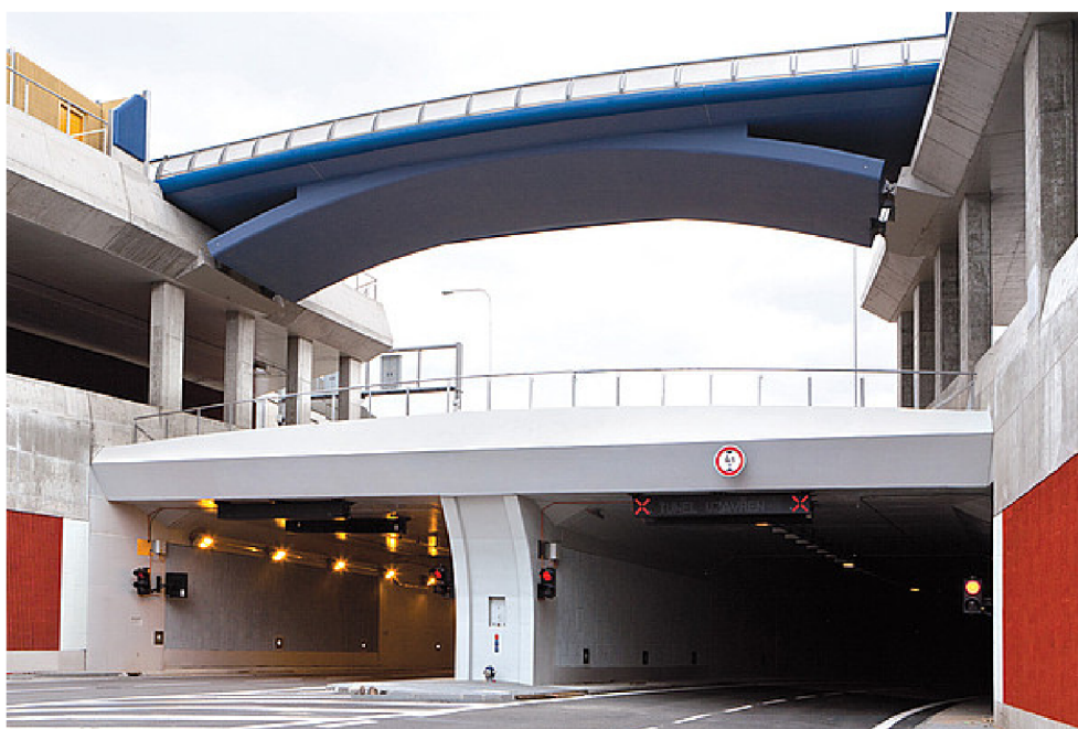
obr.9: Pohled na západní portál Královopolského tunelu. [zdroj: Omega Design]
