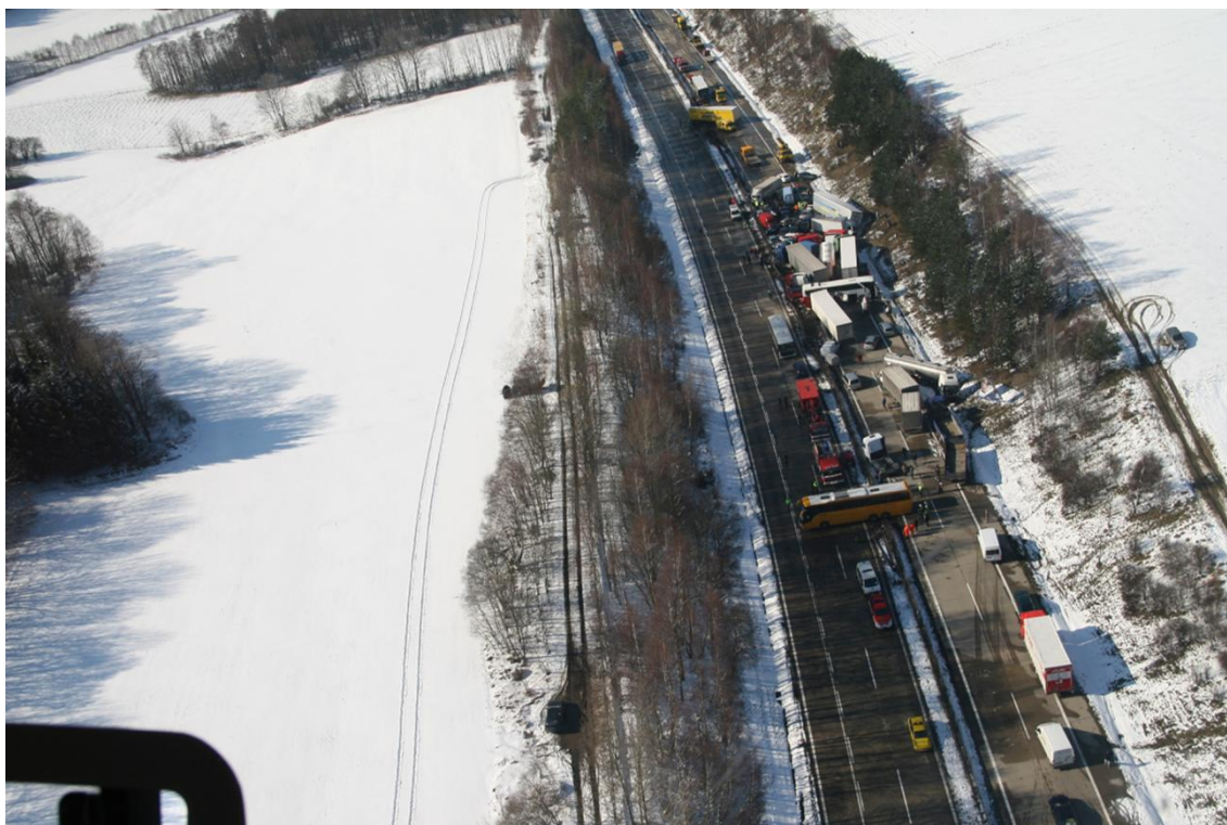
Obrázek 5. – Pohled na DI v místě kde byly odstraněny středové svodidla.
