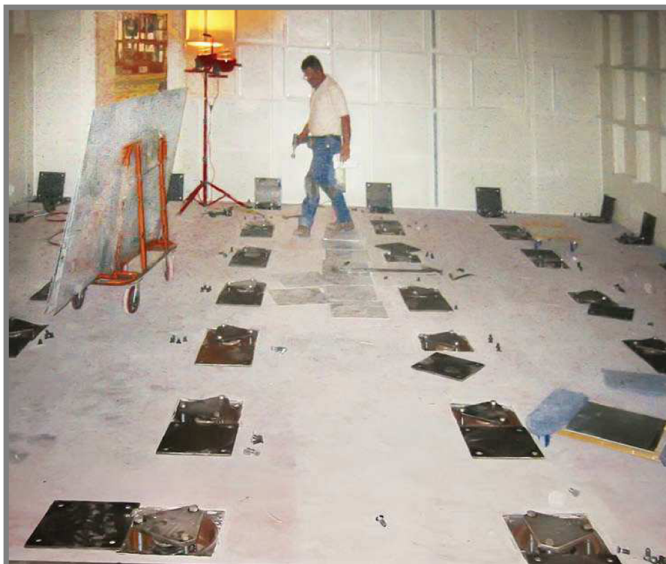
Obr. 7 Uložení komory na pružinách [17]
