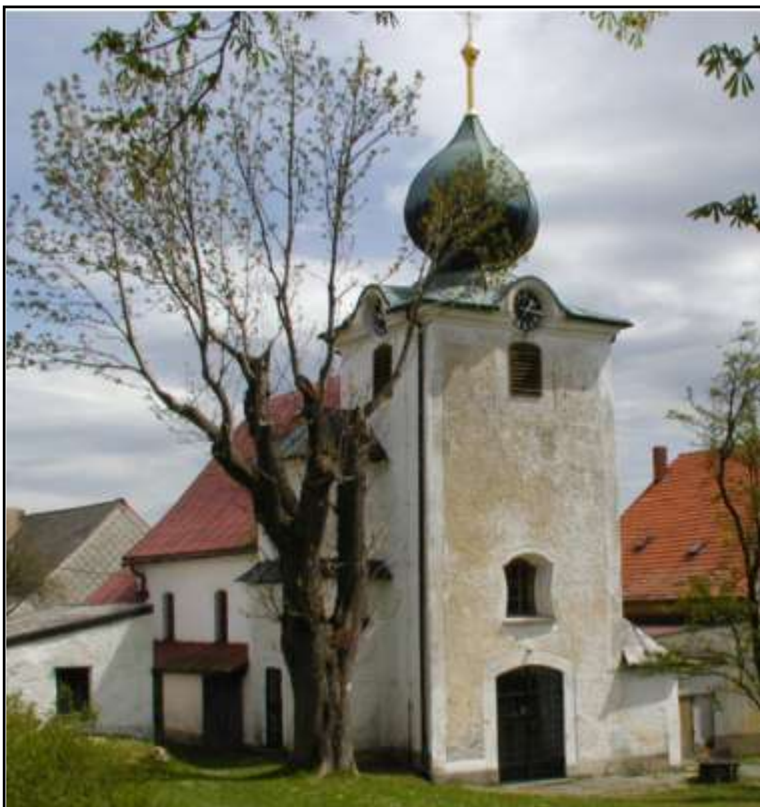
obr. č. 15: Kostel Jména Panny Marie (Zdroj: foto autor, jaro 2010)
