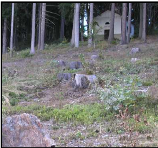
obr. č. 18: Kaple po vichřici Kyrill 2007 (Zdroj: foto Antonín Kopp)
