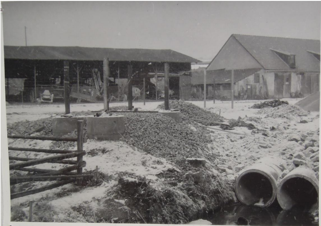
Rok 1953 - Na místě zavezeného rybníka na trávnících byl zbudován přístřešek JZD (Zdroj: Kronika obce Senetářov)
