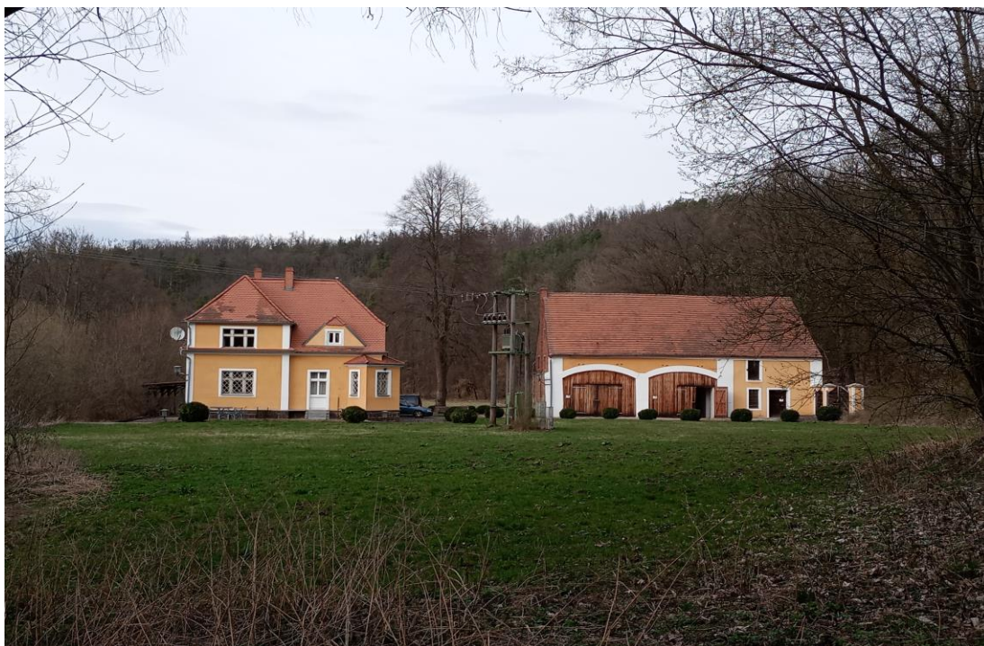
Obr. 9: Stavba 98 a st. 36/1 (autor, 2024).
