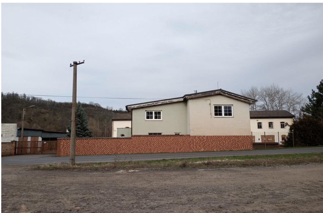
Obr. 8: Stavba pro administrativu 451/1 (autor, 2024).
