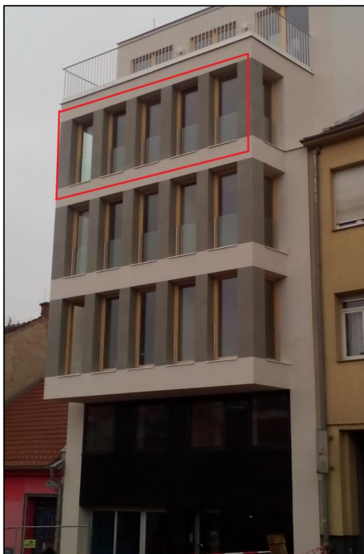
Obr. 26 – Bytový dům Minská
