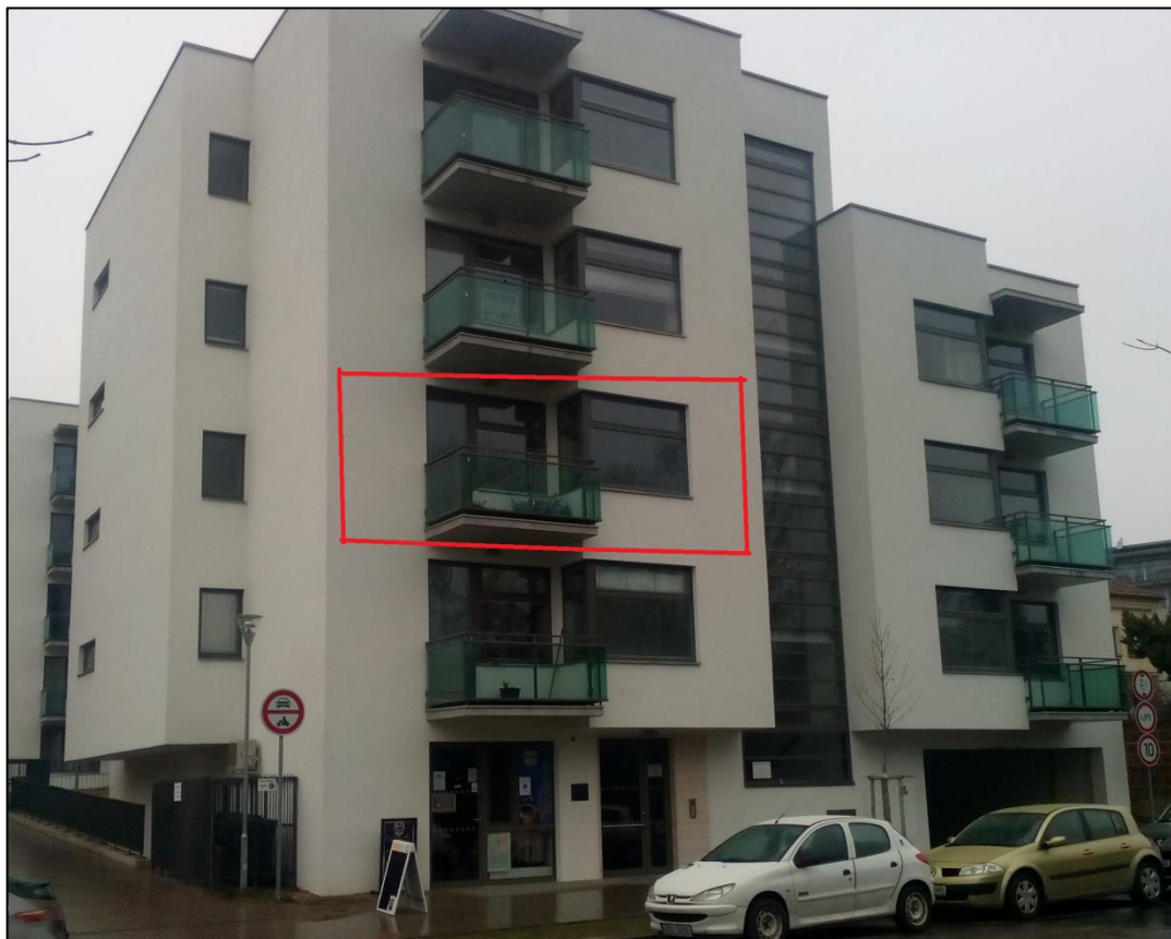
Obr. 41 – Bytový dům Božetěchova
