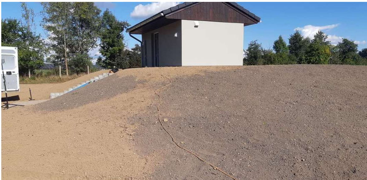
Obrázek č. 3 - Stavba nového vodojemu
