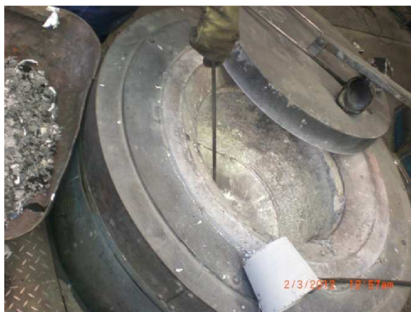
Obr.: 4.18 Elektrická odporová udržovací pec 1
