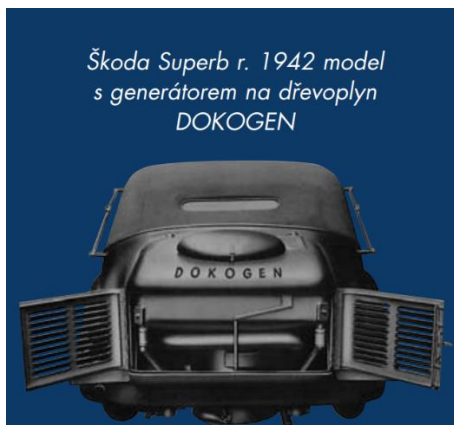
Obrázek 17: generátor na dřevoplyn 1942 a 1985 [22]
