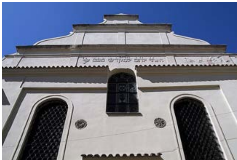
Obrázek č. 38 / Synagoga - průčelí
