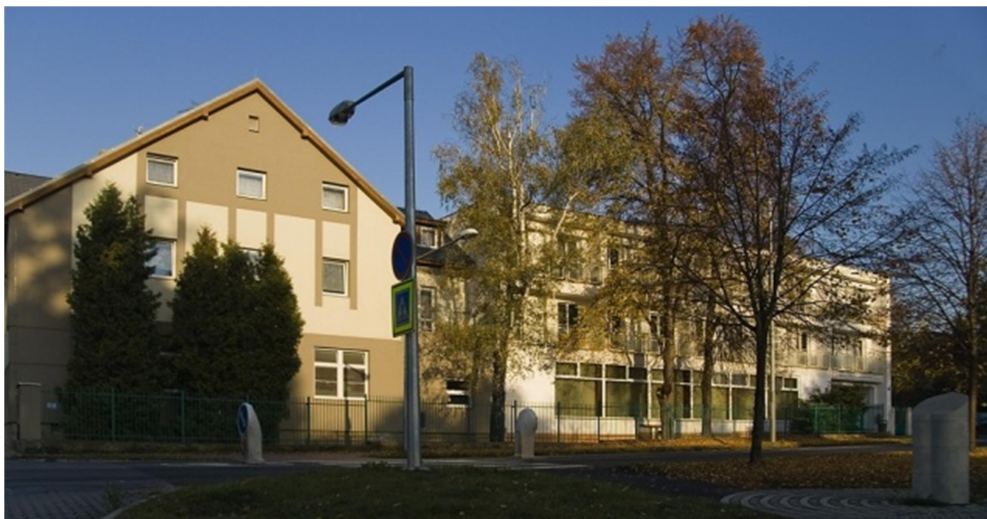
Obrázek č. 2: Budova školy
