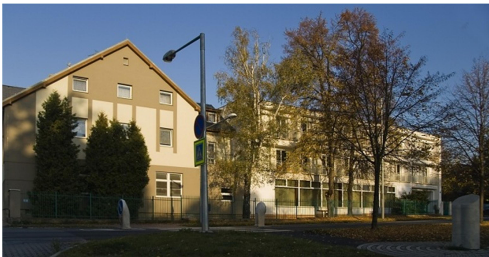
Obrázek č. 2: Budova školy
