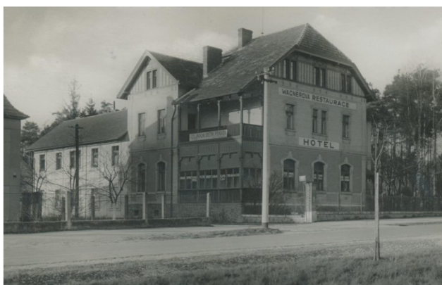
Obrázek č. 1: Restaurace a hotel Wágner
