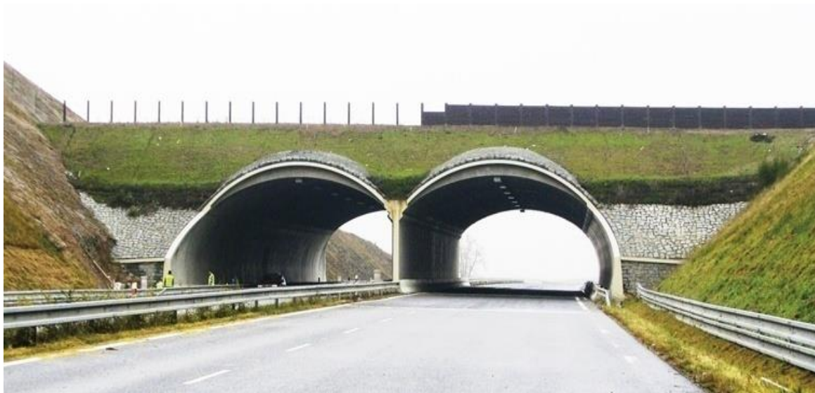
Obrázek 13: Přesypávaný tunel u Písku (MAŠÍN, 2018)
