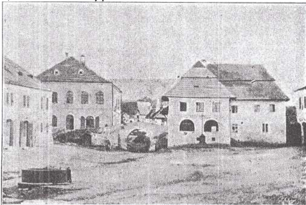
A) Původní budova školy před r. 1878.
