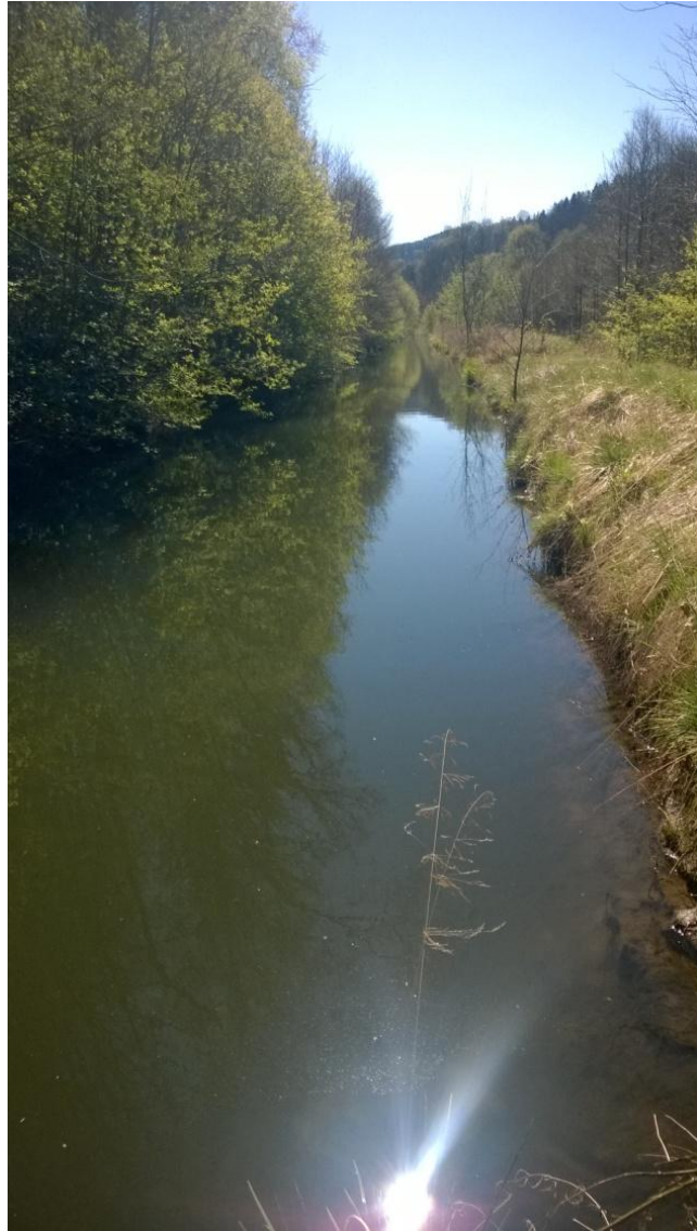
Obr. č. 4 Přivaděč vody
