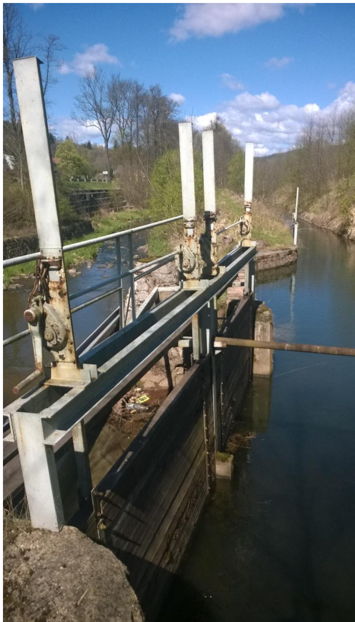
Obr. č. 3 Vtokový objekt
