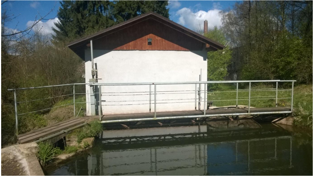
Obr. č. 6 Strojovna MVE
