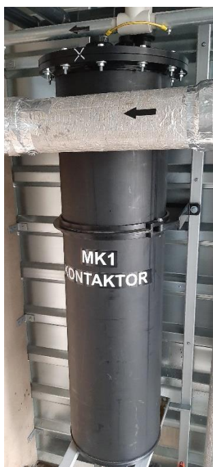
Obrázek 21 Membránový kontaktor se zabudovanými 20 svazky dutých vláken
