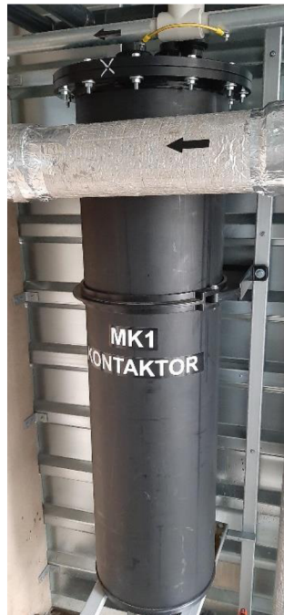
Obrázek 21 Membránový kontaktor se zabudovanými 20 svazky dutých vláken
