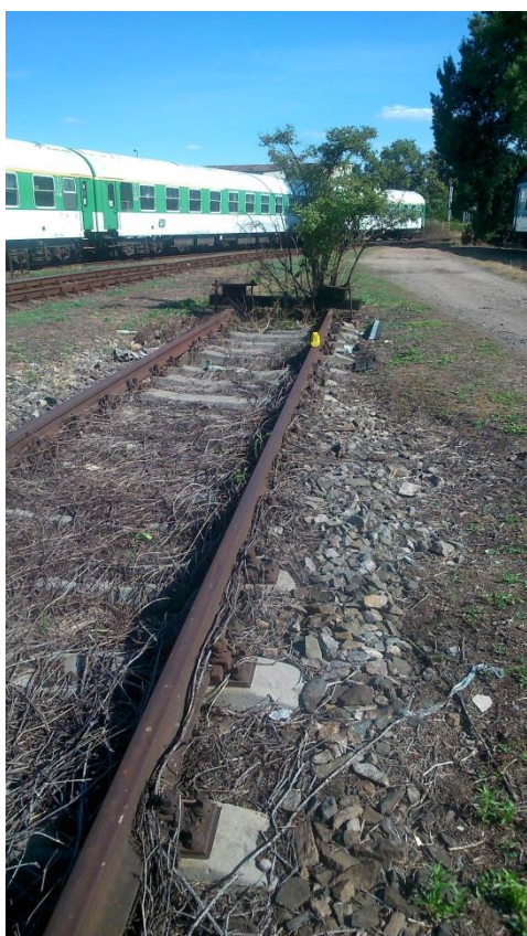
Obrázek 6: Pohled na odstavenou kolej v roce 2015 (vlastní fotodokumentace)
