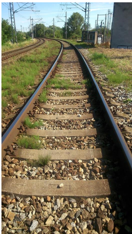
Obrázek 10: Pohled na trať v roce 2015 (vlastní fotodokumentace)
