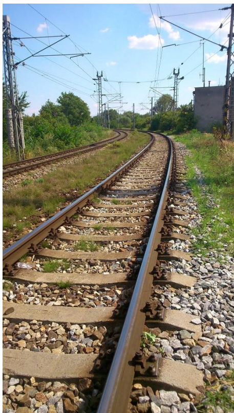
Obrázek 9: Pohled na trať v roce 2014 (vlastní fotodokumentace)
