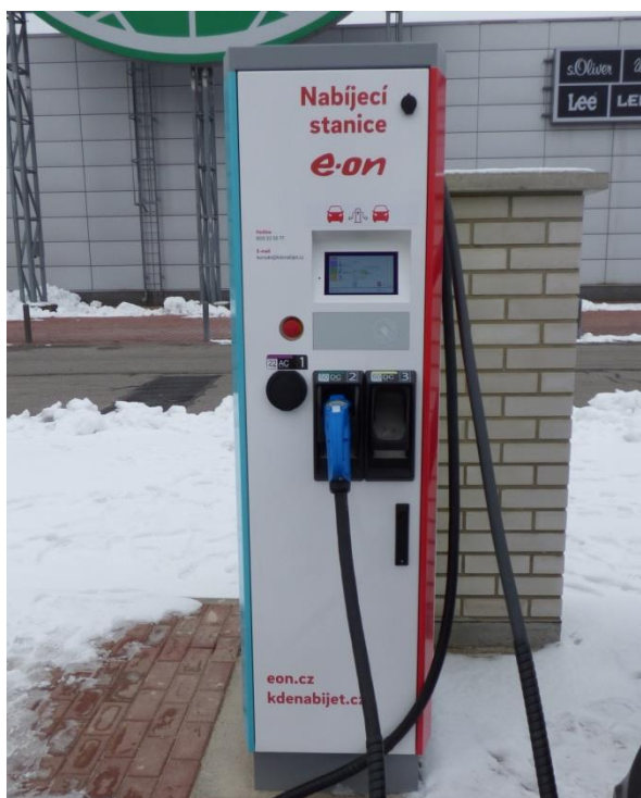
Obrázek 9 - Nabíjecí stanice E-ON 50 kW [Foto: autor]
