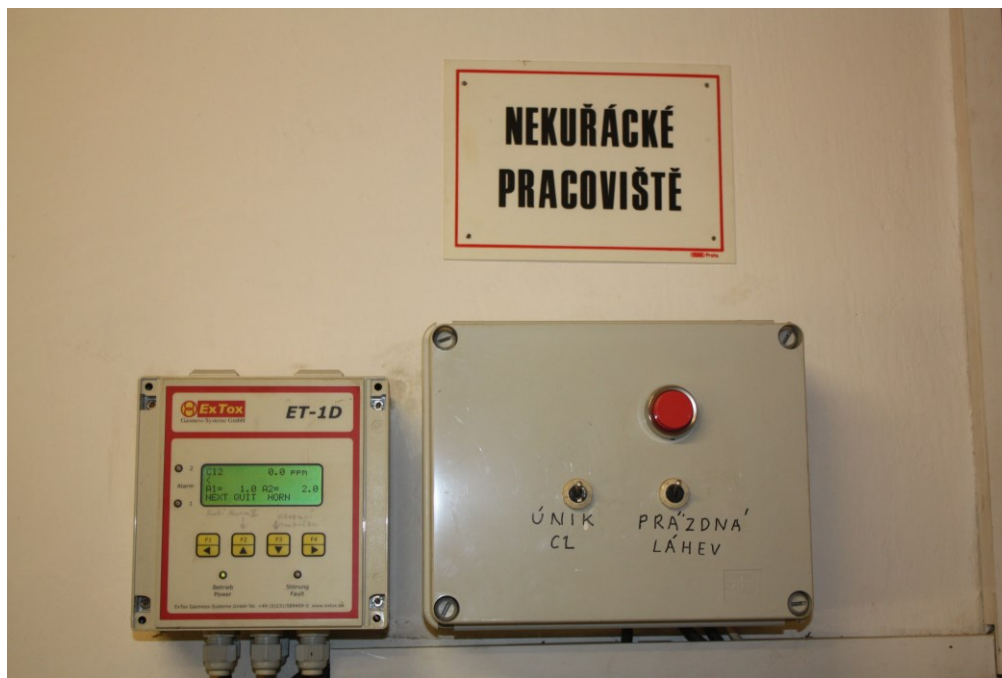
Obr. č. 8 – Signalizace pro únik chlóru a prázdné tlakové láhve [foto vlastní]
