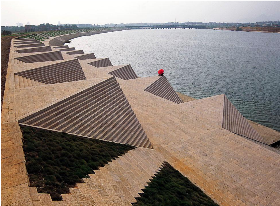
Obr. 13: Nábřeží Yiwu (realizace 2002-2004)
