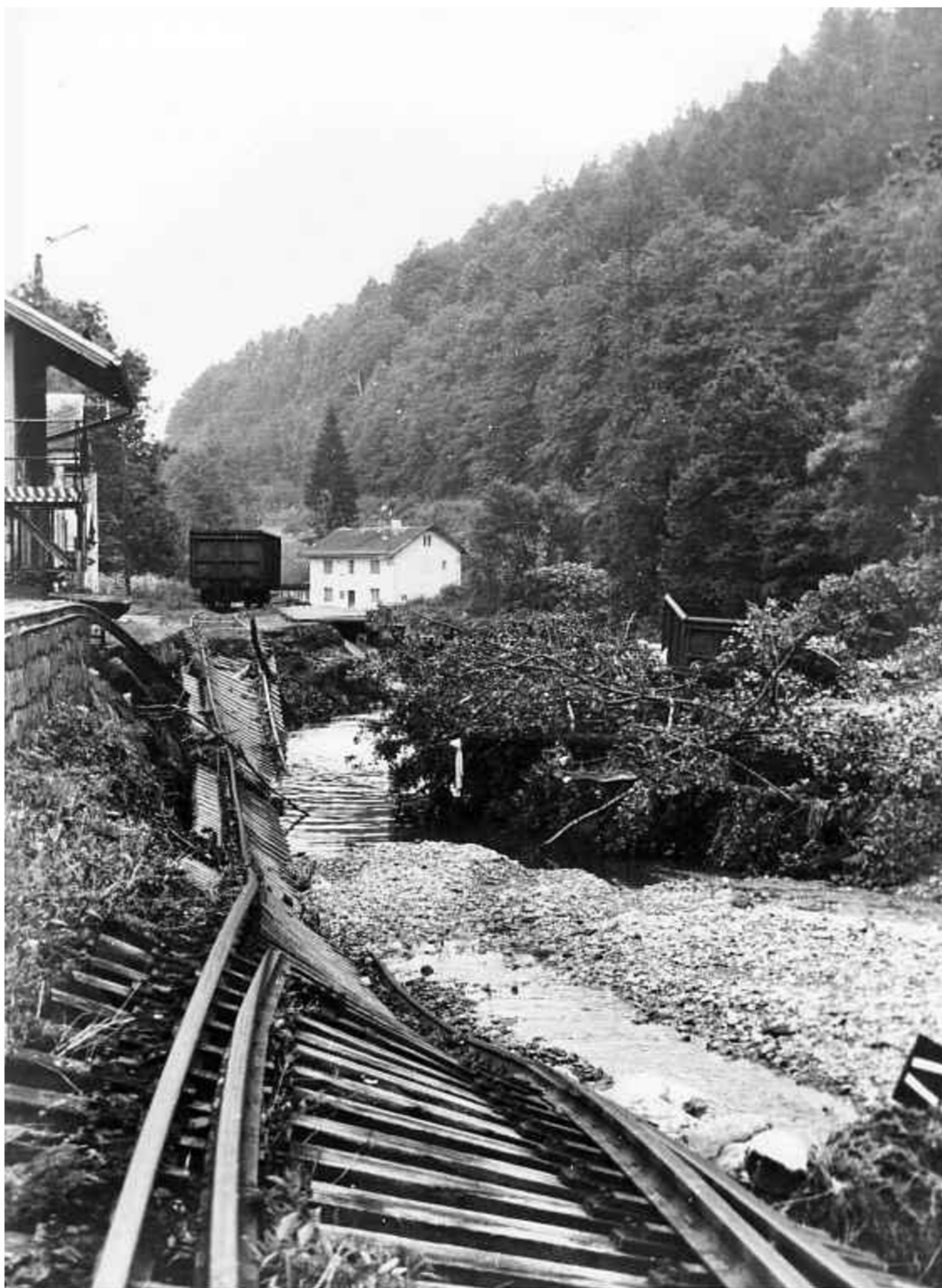
Fotografie č. 3 Poničená železniční trať v Loučné nad Desnou v červenci 1997
