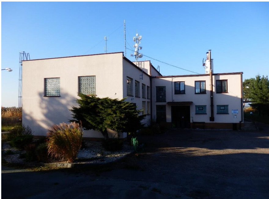
Příloha Obr.5 – Úpravna vody Mokošín (jiný úhel) (ŠAFRÁNKOVÁ, 2015 (archiv autorky))
