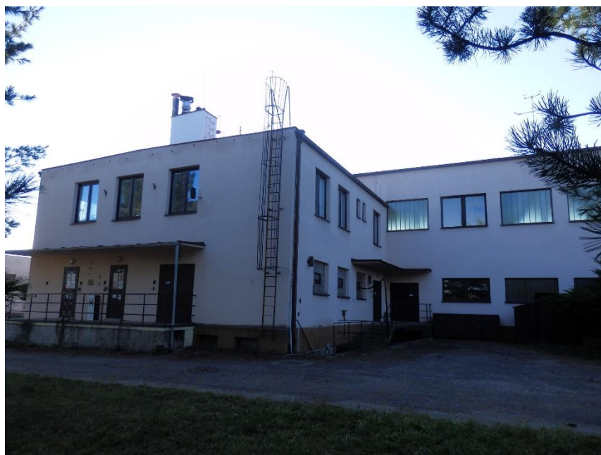
Příloha Obr.2 – Úpravna vody Mokošín (jiný úhel) (ŠAFRÁNKOVÁ, 2015 (archiv autorky))
