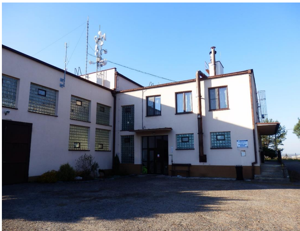
Příloha Obr.1 – Úpravna vody Mokošín (ŠAFRÁNKOVÁ, 2015 (archiv autorky))
