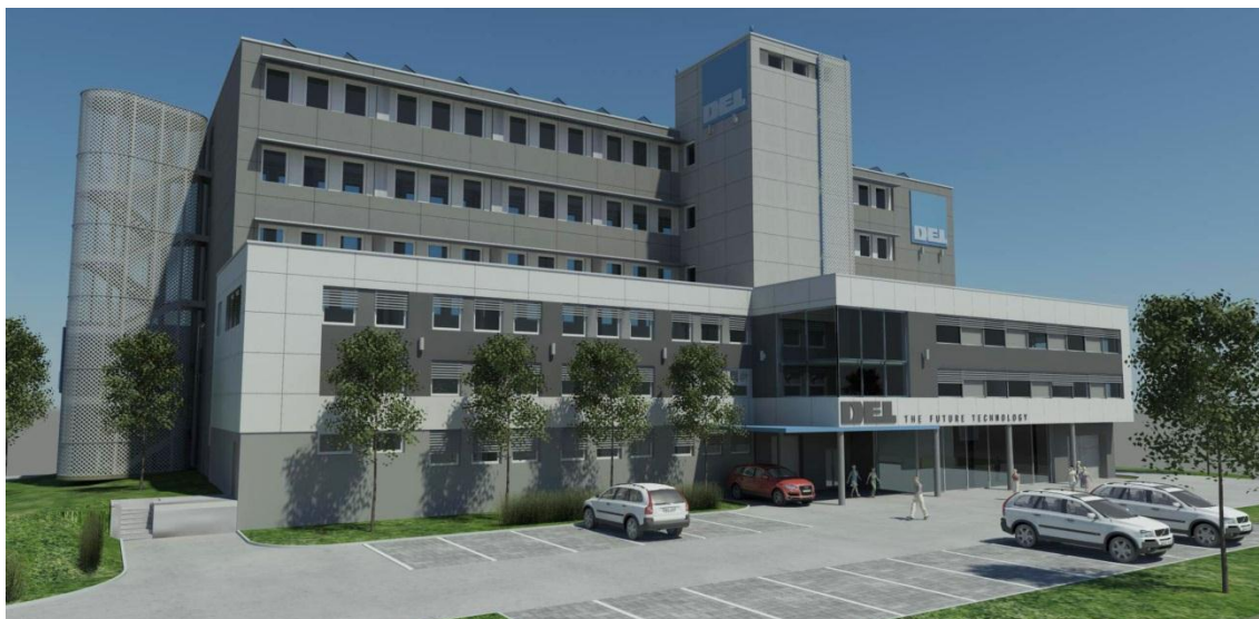
Obrázek 6.2 Administrativní budova DEL a.s.
