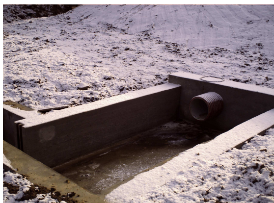
Obr. V. 8: Stavba výpustě 4 - dokončení
