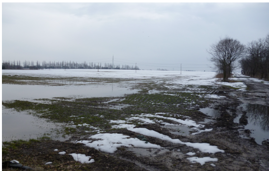
Obr. VIII.1: Rybník Pilar (pohled z hráze)
