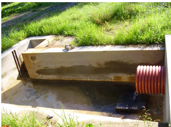
Obr. V. 12: Výpust mezi rybníky R1 a R2
