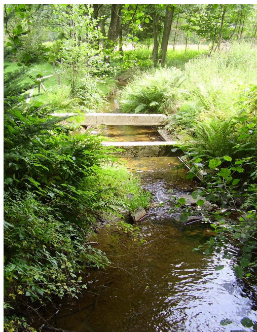
Obr. V. 2: Bílovka nad budoucími rybníky
