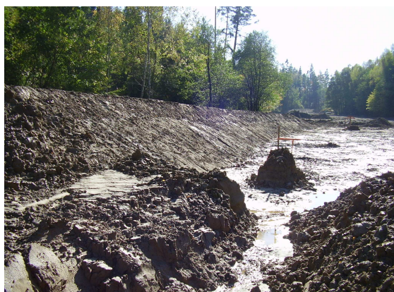
Obr. V. 6: Budování hráze (foceno ze dna budoucího rybníka R1)
