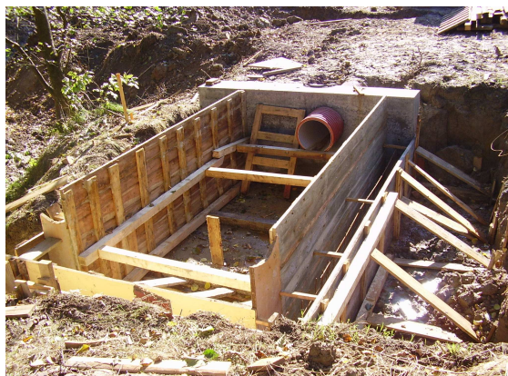
Obr. V. 4: Stavba výpustě 2
