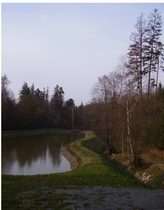
Obr. V. 18: Nádrž R1 a obvodový kanál
