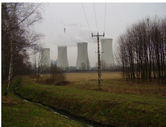
Obr. VIII.3: Dětmarovická elektrárna (pohled z místa rybníku Otec)
