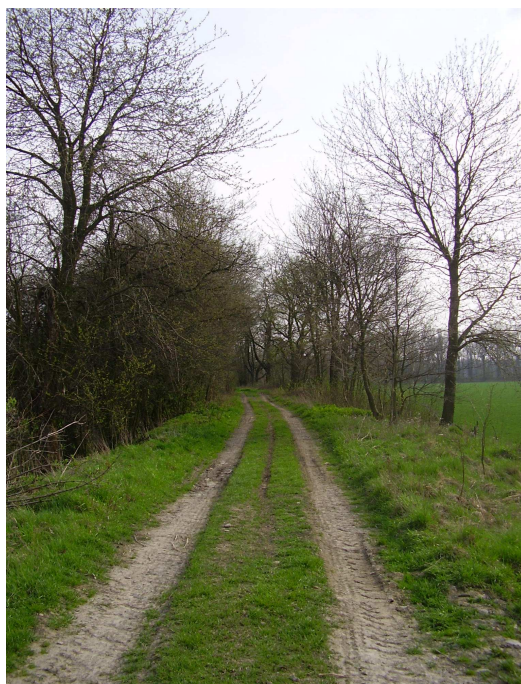
Obr. 9: Téměř zarovnaná hráz mezi bývalými rybníky
