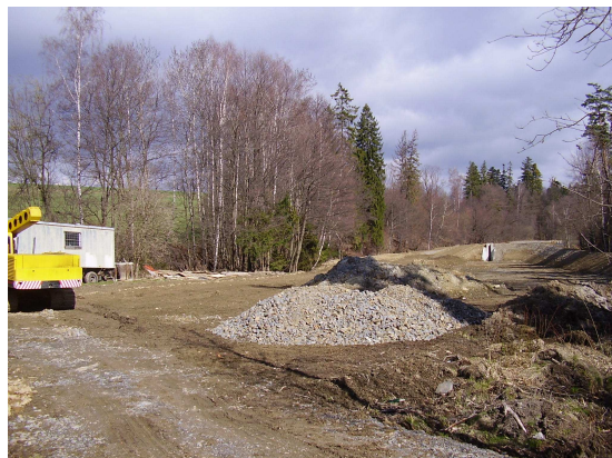
Obr. V. 11: Probíhající stavba rybníku R2
