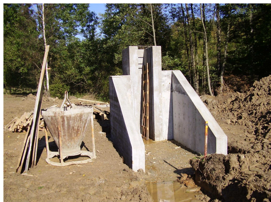
Obr. V. 5: Stavba výpustě 3
