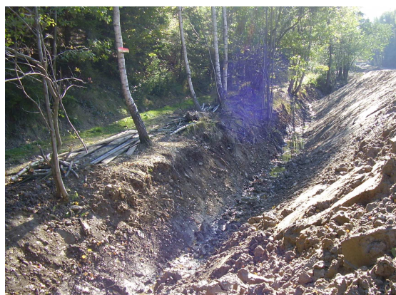
Obr. V. 7: Hloubení obtokového kanálu
