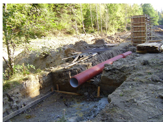
Obr. V. 3: Stavba výpustí
