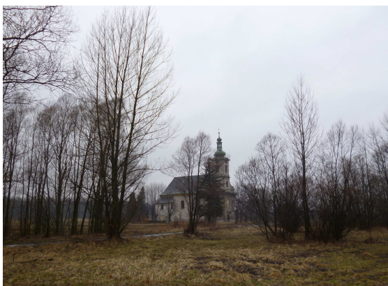
Obr. II. 4: Opuštěný kostel v Loučkách
