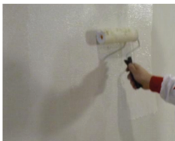
Obr. 13: Nanášení penetrační vrstvy [1]
