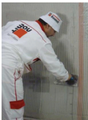
Obr. 12: Nanášení základní vrstvy [1]
