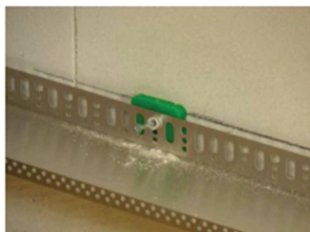
Obr. 4: Soklová distanční podložka [1]
